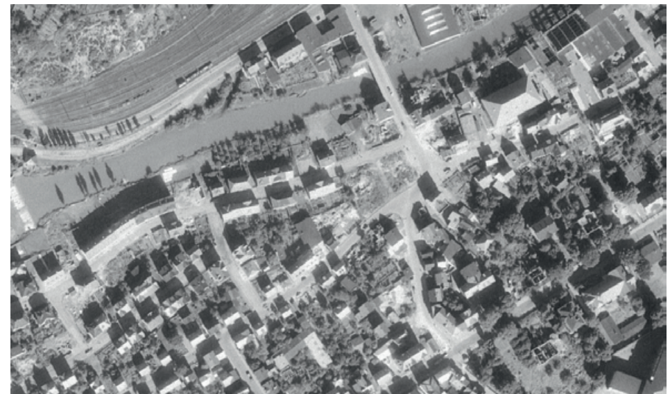
2 Luftbild Siegen, 1951, Ausschnitt Hammerhütte mit noch sichtbaren Kriegszerstörungen (1944), im Zentrum das bereits 1940 durch Explosion zerstörte Areal des historischen Hammerwerks, südlich davon der Gasthof Klein
