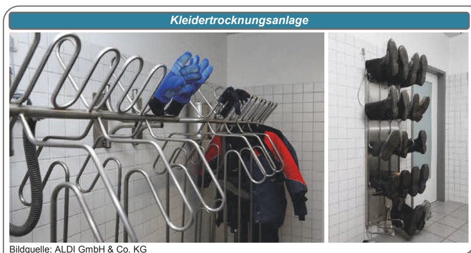
Abb. 2.10: Im Warenverteilzentrum eingesetzte Kleidertrocknungsanlage für den Kälteschutzanzug (links) und die Kälteschutzstiefel (rechts)
