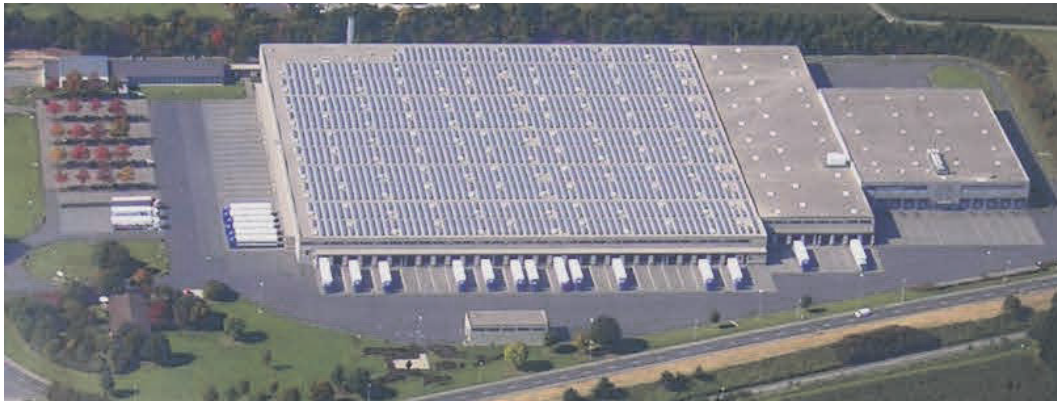
Abb. 2.1: Luftaufnahme des Warenverteilzentrums in dem die Untersuchungen stattfanden mit einem Trockenlager (links) sowie einem Kühl- und Tiefkühlager (rechts, kleiner Anbau) (Bildquelle: Dr. Jörg Schneider)
