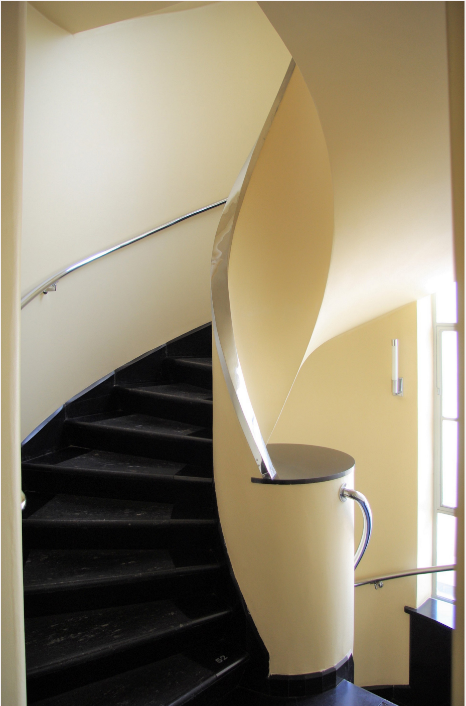
Abb. 2_20 Haupttreppe mit restaurierten Chromteilen, eigene Fotografie 2015.
