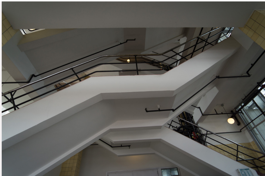
Abb. 3_04 Van Nelle Fabrik, scherenförmiges Treppenhaus im Produktionsbereich, eigene Fotografie 2015 .
