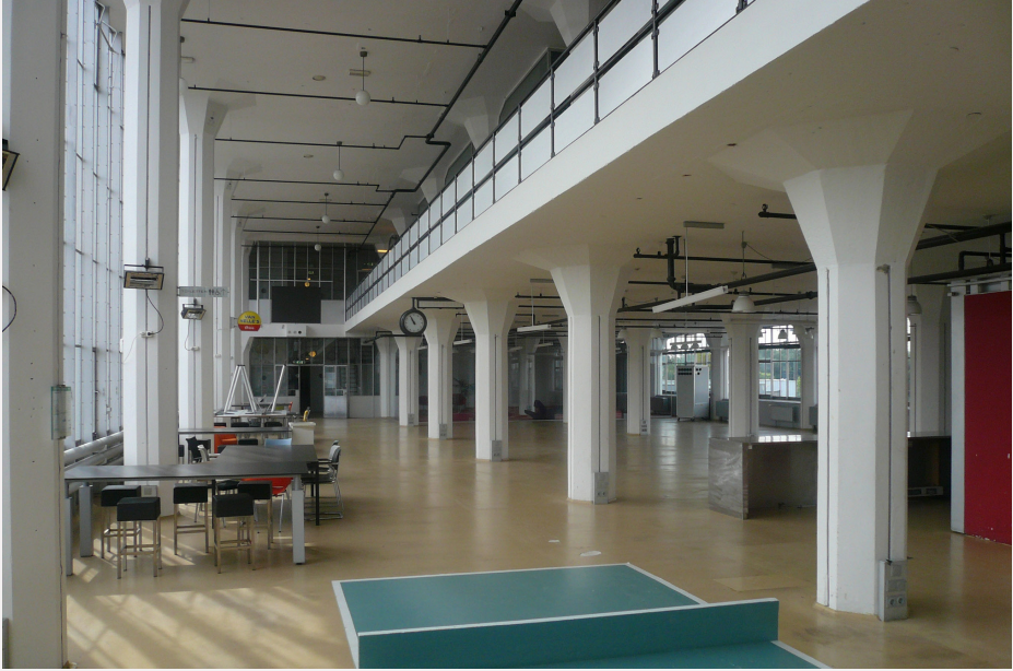
Abb. 3_07 Van Nelle Fabrik, Blick vom Erdgeschoss auf die Empore im Produktionsbereich nach Sanierung, eigene Fotografie 2015 .
