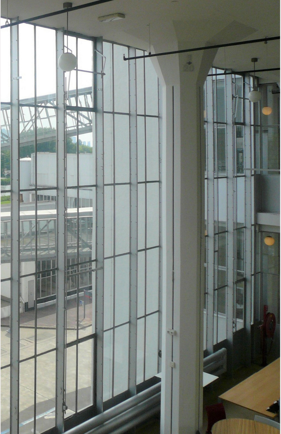
Abb. 2_04 Van Nelle Fabrik, Pilzkopfstütze in der Produktionshalle, eigene Fotografie 2015.
