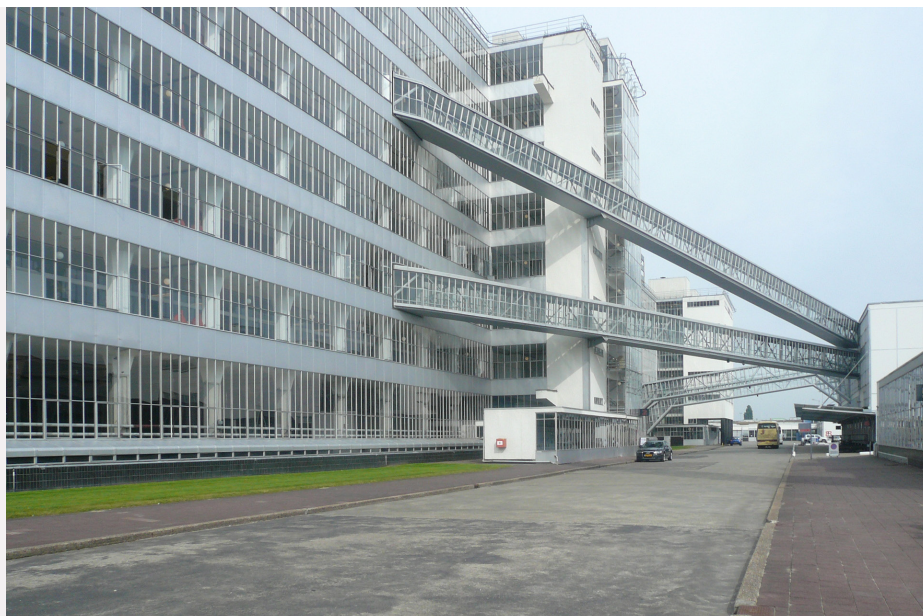
Abb. 3_06 Van Nelle Fabrik, Fassade des Produktionsbereichs mit Transportbrücken, eigene Fotografie 2015.
